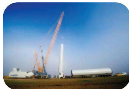
Livraison et Montage des tronçons de mâts
