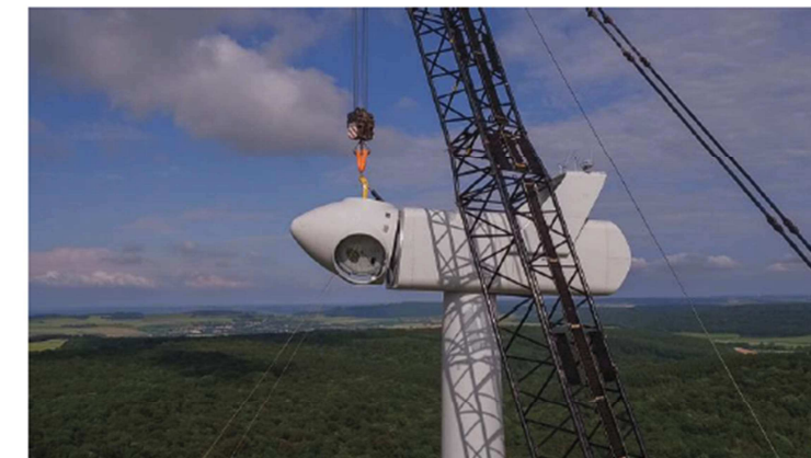
Figure 7 : Installation du hub sur l'éolienne n°6
