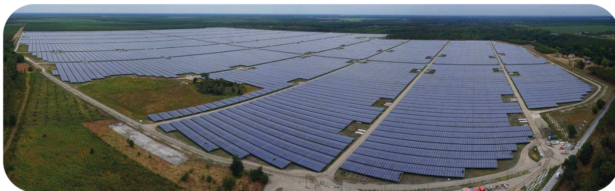
Figure 6 : Chantier de la centrale photovoltaïque de Cestas (300 MW)
