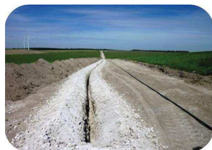
Réalisation des pistes et du câblage
