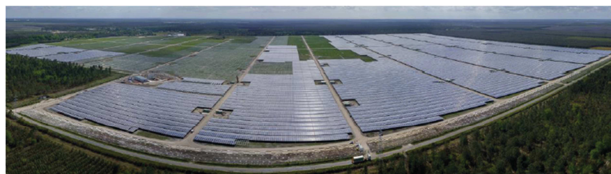
Figure 2: Parc photovoltaïque de Cestas en construction - mai 2015
