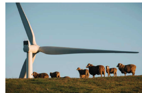
Figure 4 : Une des éoliennes de Hornsdale 1 - juillet 2016
