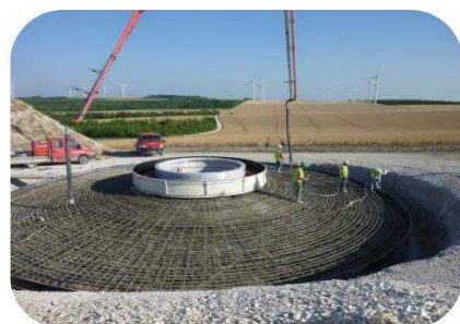
Coulage de la fondation
